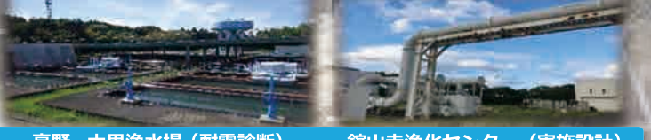
高野・大里浄水場（耐震診断） 館山寺浄化センター（実施設計）
