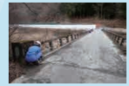
⑫ 国道152号下樽渡橋（予備・詳細設計）
