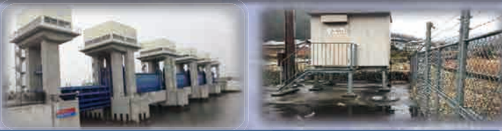
日光川水門（耐震性能照査） 大ヶ洞ダム（河川整備計画）
