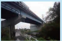
⑦ 大垣管内 橋梁（維持点検）
