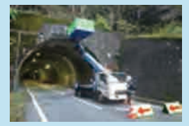
⑥ 国道257号線新日和田トンネル（維持点検）
