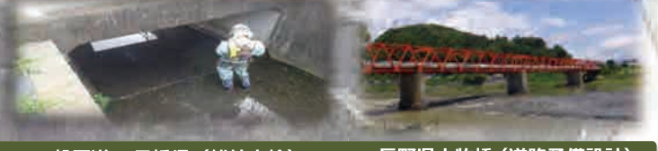
一般国道1号橋梁（維持点検） 長野県古牧橋（道路予備設計）
