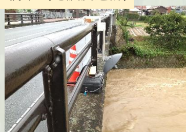
橋梁（電波流速計）
