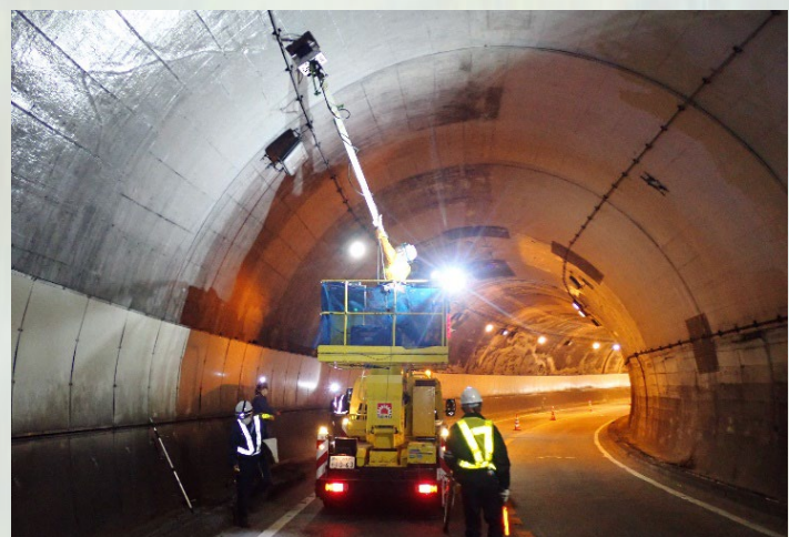
トンネル調査
