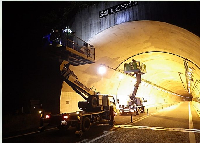
トンネル定期点検
