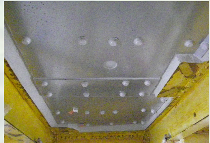
橋梁補強設計（床版補修・補強）
