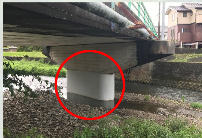
耐震補強設計（RC巻き立て）
