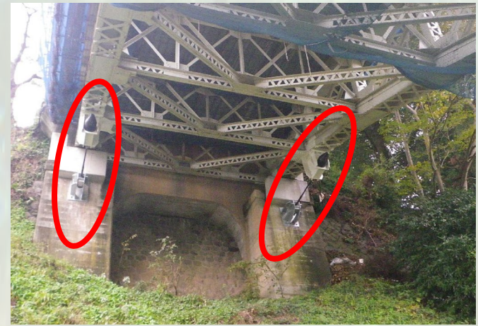
耐震補強設計（落橋防止構造）
