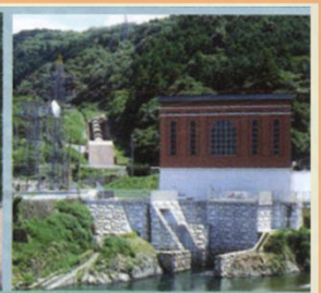
新高津尾発電所
