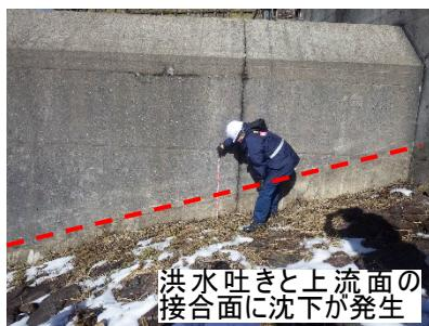
洪水吐きと上流面の接合面に沈下が発生
