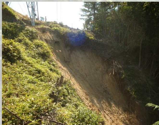
送電設備周辺で発生した土砂崩壊による応急復旧の様子です。
