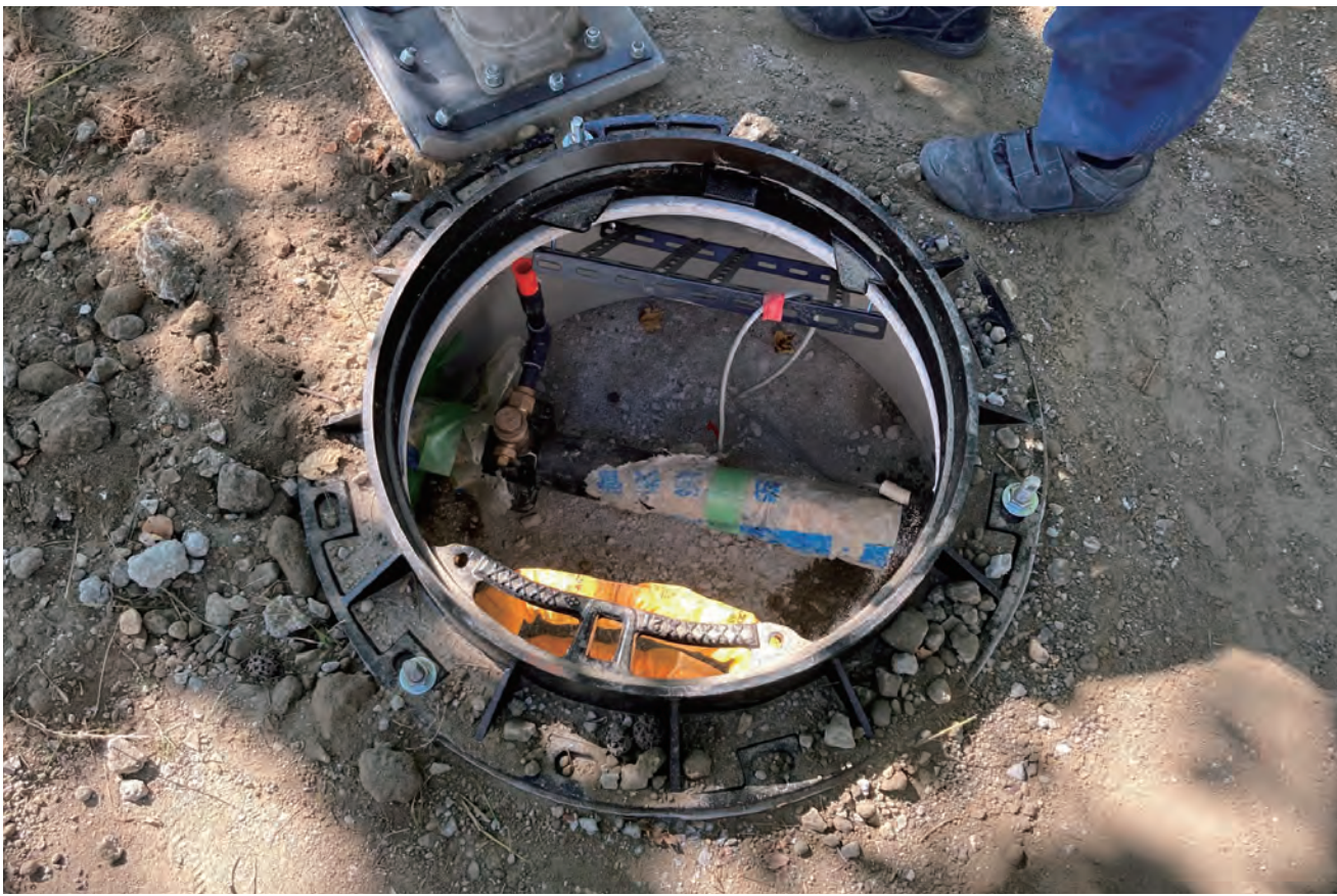
マンホール設置工事
