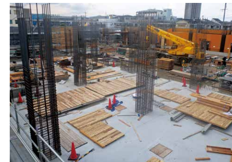
外壁杉板型枠施工状況
