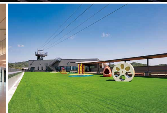
フェーズフリーに寄与する屋上広場
