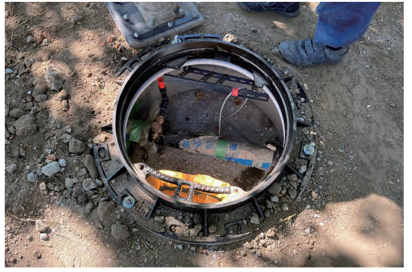
マンホール設置工事
