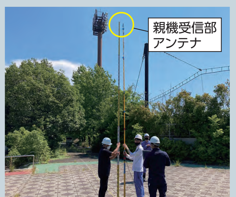
伝送システムの通信状況検証
