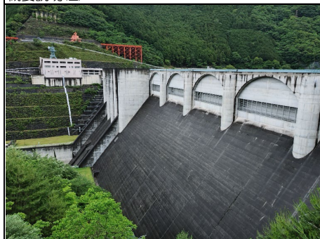
大滝ダム下流面
