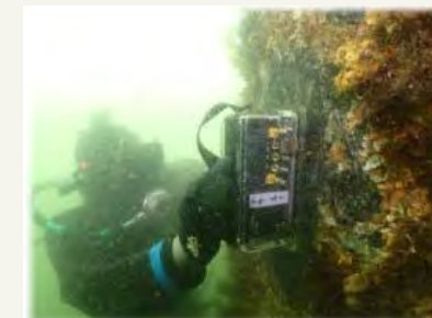
▲ 鋼管杭の傾斜角測定の様子
