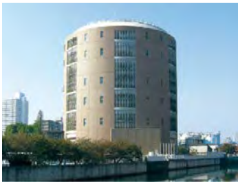
中浜下水処理場ポンプ棟
